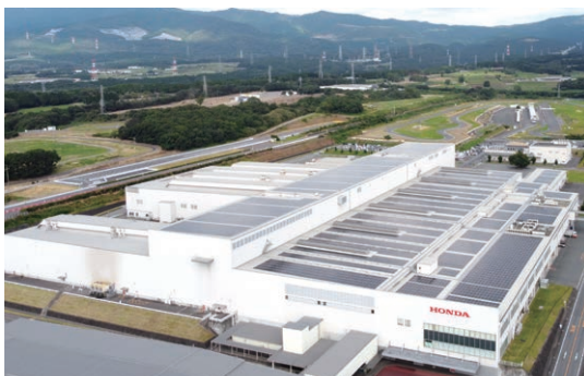
熊本製作所 (5.35MW)
